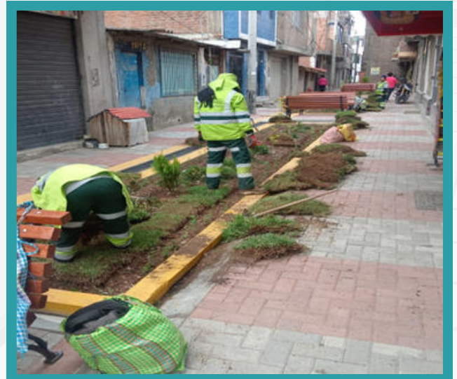
Adoquinado de grass común en el Psje. Castilla
