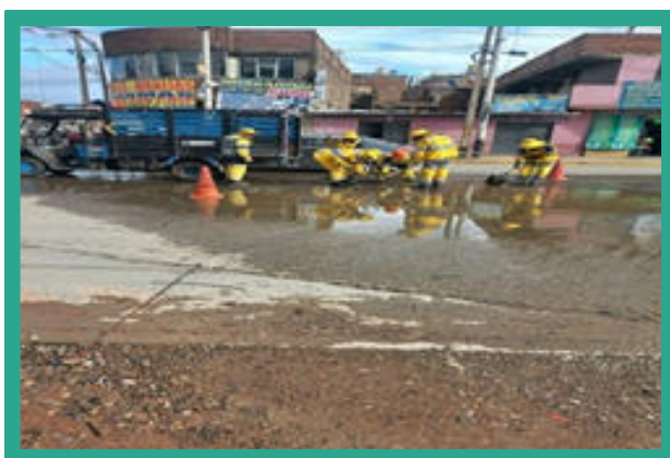
➔ Limpieza de cajas de sumideros en la Av. Ferrocarril
