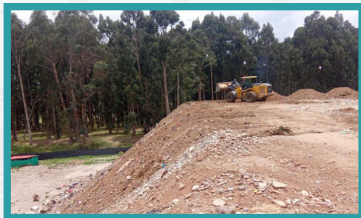
Compactación de residuos sólidos
