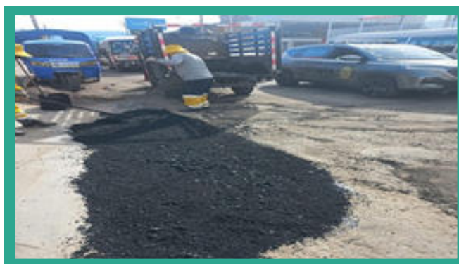
➔ Bacheo de pavimento flexible en la Av. Marical Castilla
