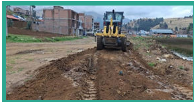
➔ Perfilado y compactado de vía no pavimentada en anexo de Cullpa Alta
