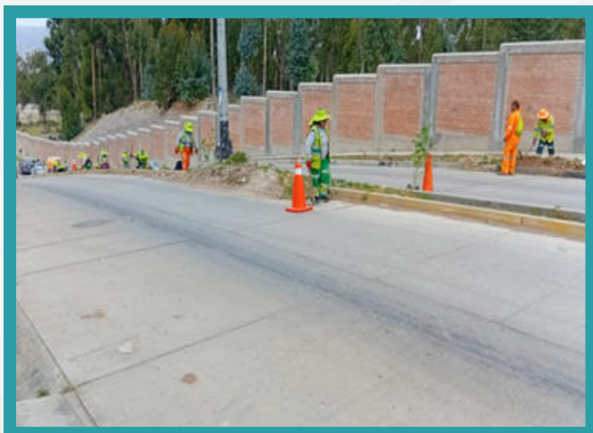
Reforestación de la Berma Central y lateral de la Av. Cantuta.
